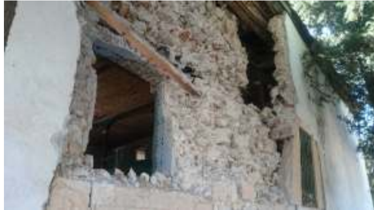
Fotoğraf.1- Akarca Köyü Cami. Doğu cephe.
