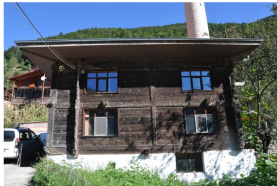
Şekil 7. Filak Mahallesi Ahşap Cami Güney Cephesi
