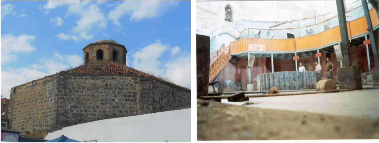
Fotoğraf 9 & 10. Deve Hamamı'nın dıştan ve içten görünüşü (Kaynak: Yazar Arşivi, 2014).
