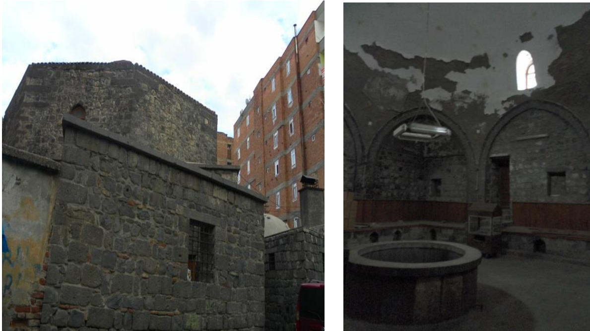
Fotoğraf 11 & 12. Kadı Hamamı'nın dıştan ve içten görünüşü (Kaynak: Yazar Arşivi, 2014).
